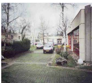
Tranchée autour d'un bâtiment
