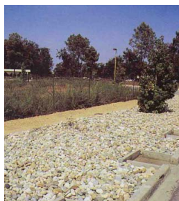
Tranchée sous trottoir
