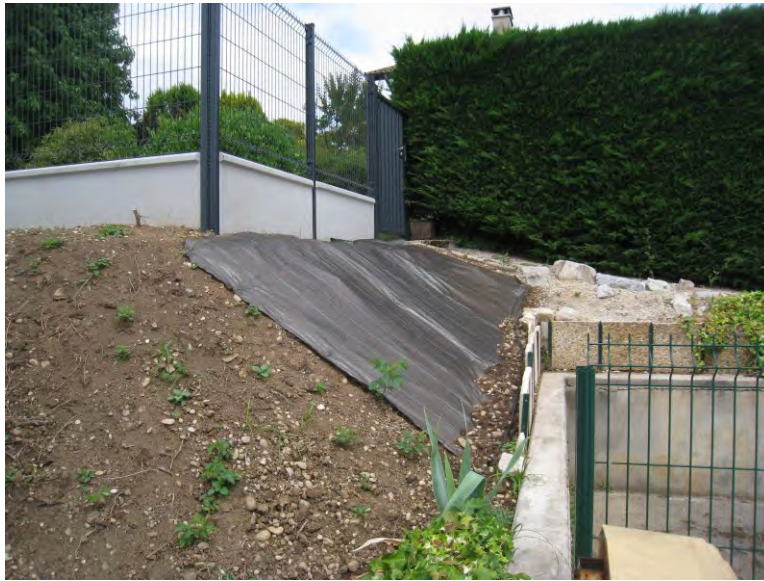
Photo 35 : bâche « Paillex » sur talus.
