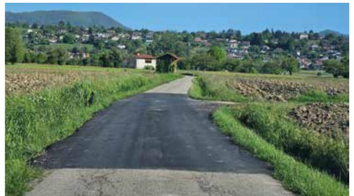
Chemin de Pré Novel : reprise d'une partie du chemin en enrobé soit 120m<sup>2</sup> et création de 5 voies de garage pour que les véhicules puissent se croiser.
