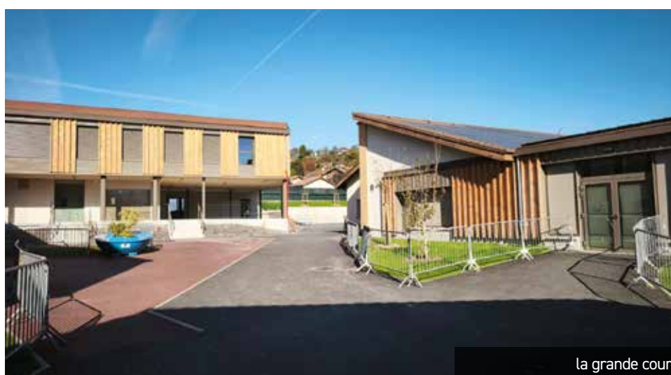
cour Citrouille et escalier neuf
